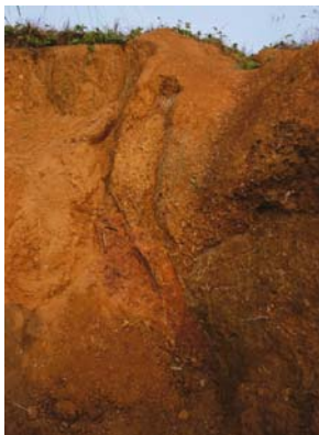
图 10 探槽局部剖面照片(镜向 70°)
