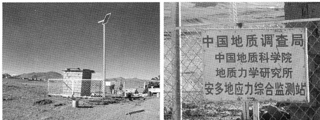
图 8 安多地应力监测站外貌
