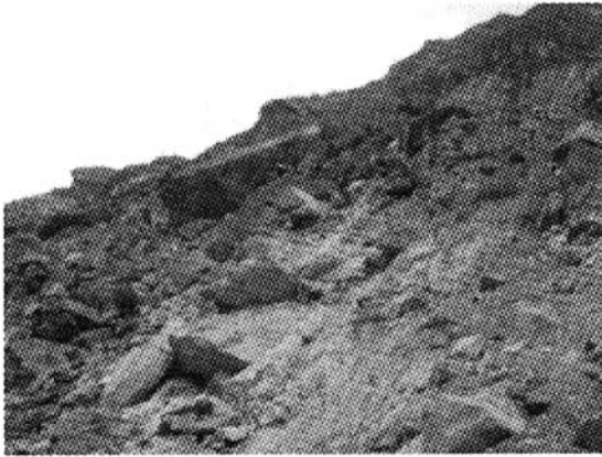
图4 香格里拉县核桃园附近崩塌
