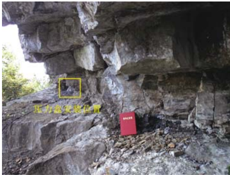
图 5 压力盒安装位置
