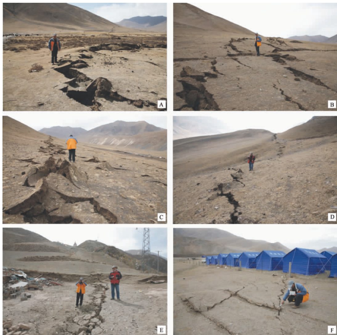
图 6 甘孜-玉树断裂带玉树地震地表破裂特征 (据文献 [45])
