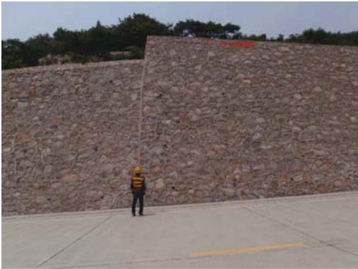
图 1 过境道路路堑挡墙
