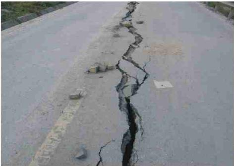
E. 地震导致混凝土路面开裂(镜向W)
