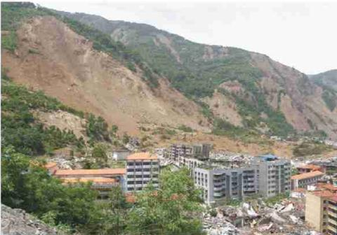
E. 北川县老城区西侧复活型老滑坡掩埋房屋(镜向NW)
