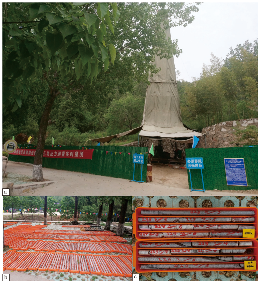
a—地应力测量与实时监测钻孔施工现场图; b—钻孔岩芯摆样图; c—典型钻孔岩芯图
