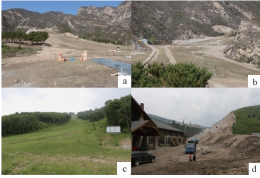
a—石京龙滑雪场滑道地貌与泥石流冲积扇； b—石京龙滑雪场泥石流沟沟口；c—云顶山滑雪场滑道地貌； d—云顶山滑雪场运动员公寓人工切坡
